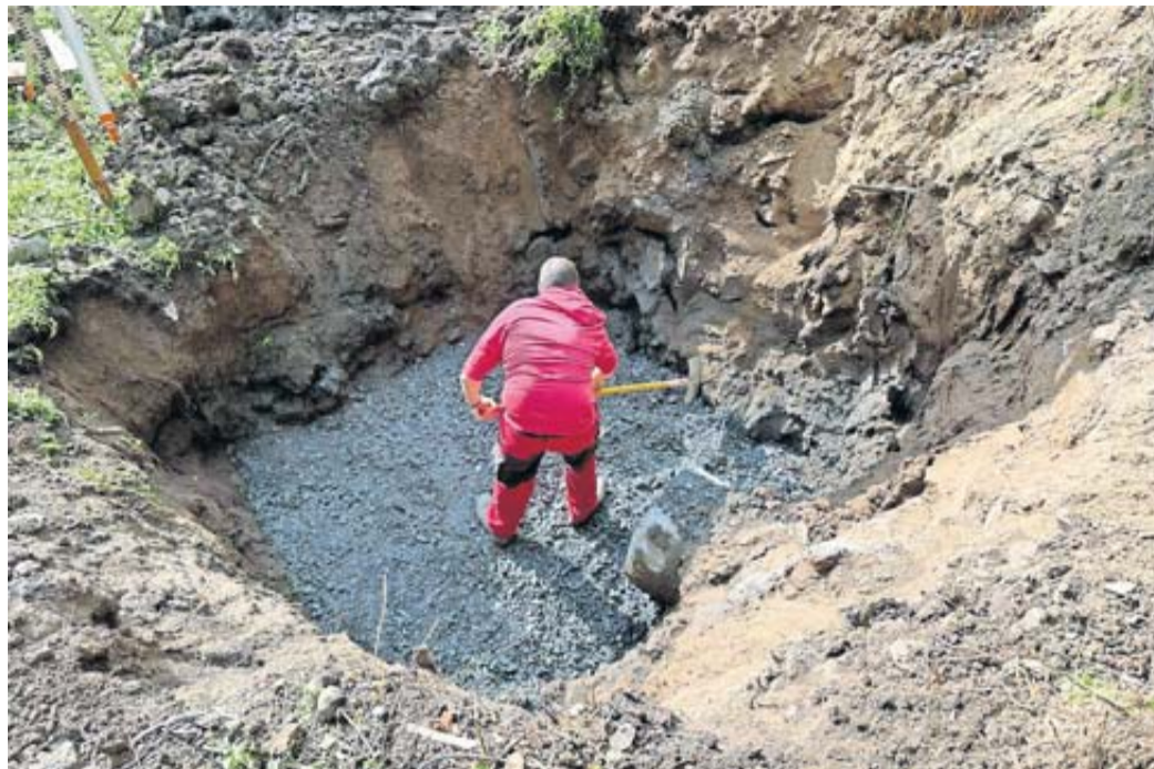
Sanierungsarbeiten am Karlsteich.
