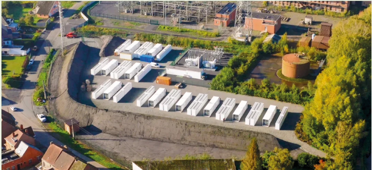
Abb. 18: Drohnenaufnahme von Deux Acren während der Bauphase
