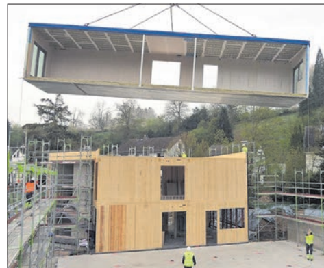
Die ersten Module wurden im April eingebaut. Foto: Jochen Haupt
