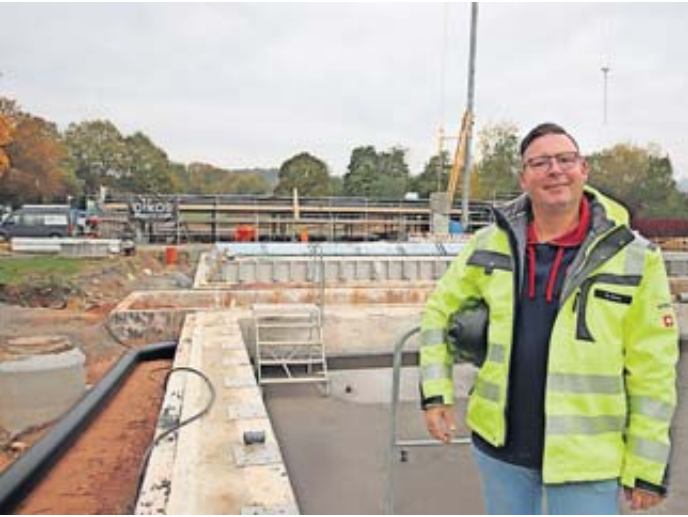
Bauleiter Mario Zirkel ist stolz auf den Baufortschritt. Im Hintergrund ist das Dach für die künftigen Mietkabinen erkennbar. Foto: Stadt Schlüchtern
