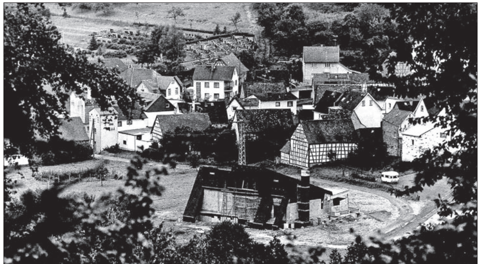
Die Dattenbachhalle wird gebaut – Blick vom Wohngebiet Feldbergstraße 1973/74 Richtung Friedhof. Foto: Stadt Eppstein
