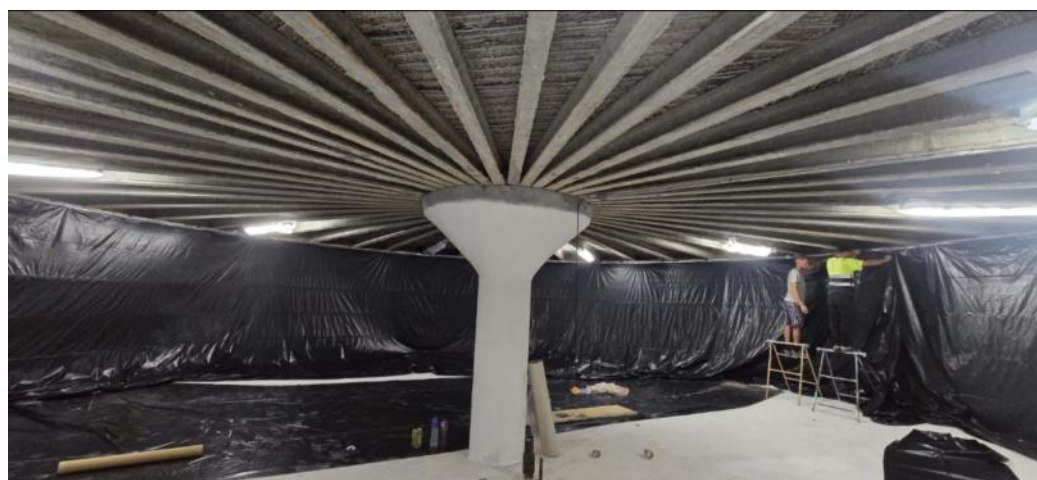
Reparatur des großen Wassertanks
