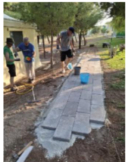
Dienst Camp, neue Wege werden gepflastert
