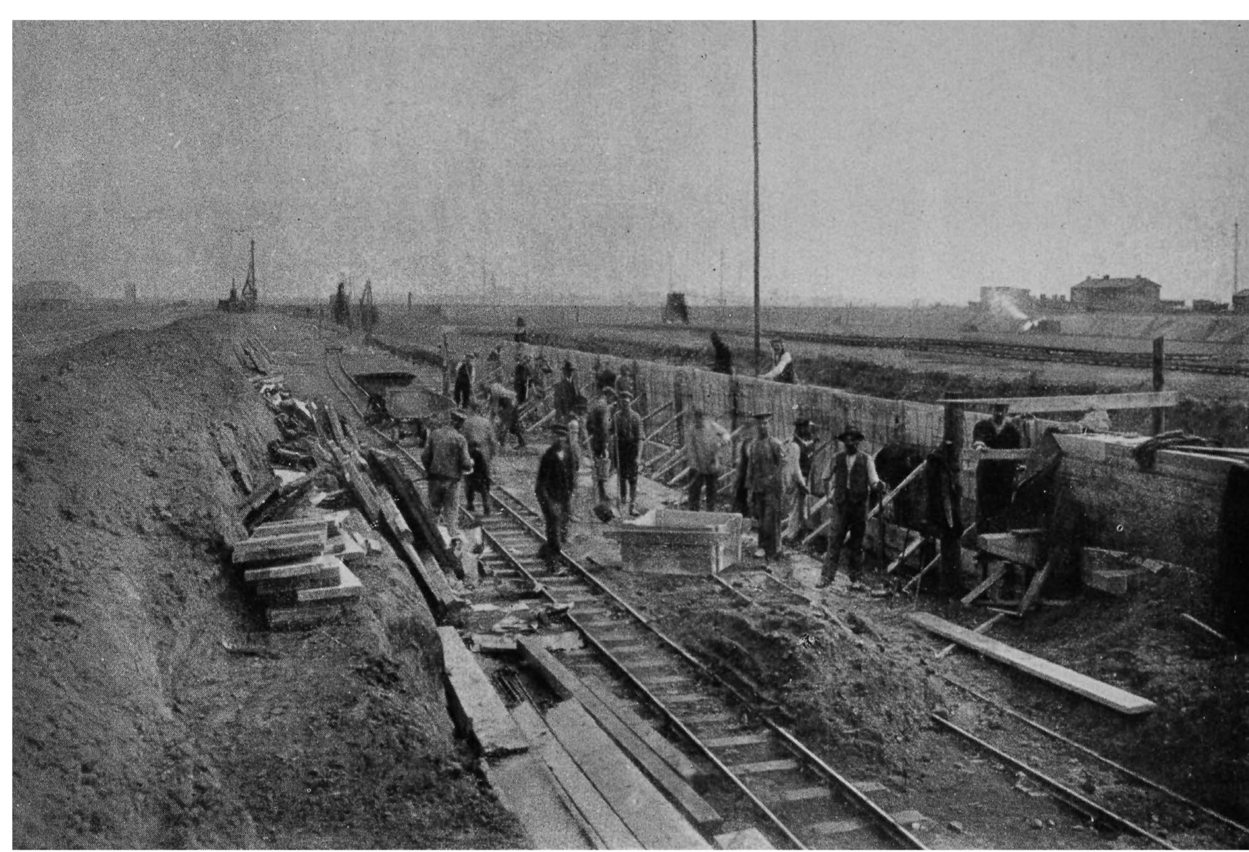
Arbeiter bei der Betonierung des Kranholms 1921. Entsprechend der Arbeitsordnung des Arbeitsamts wurden die Erwerbslosen einem Bauunternehmen zugeteilt, ihre wöchentliche Arbeitszeit betrug 48 Stunden.
