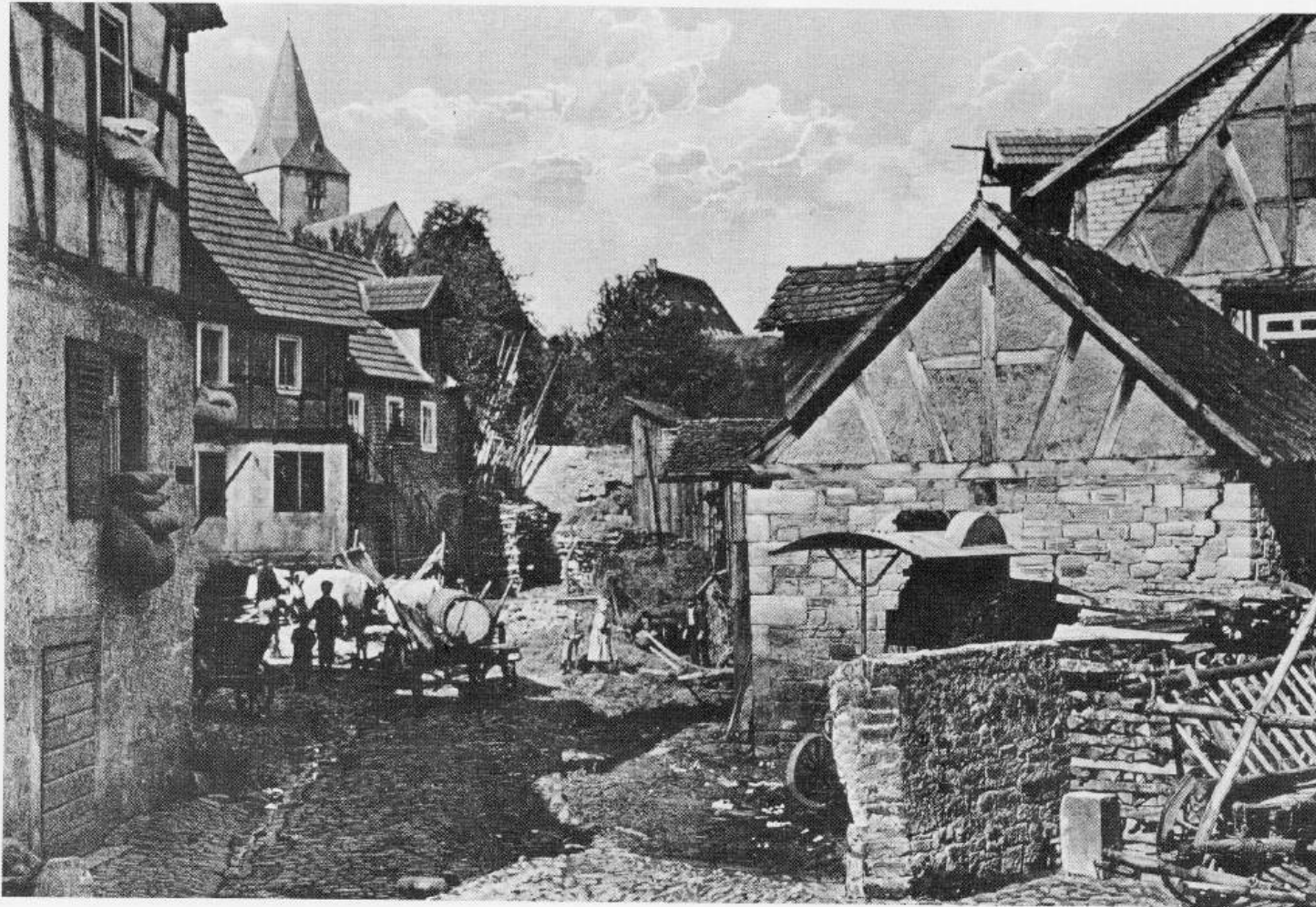
Der Freihof von der Kanalstraße aus gesehen. Foto aus dem Jahre 1928.
