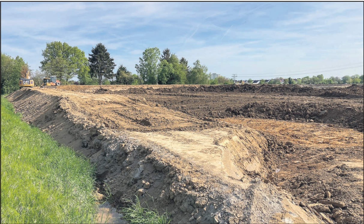
Regenrückhaltebecken an der Waldstraße, derzeit in der Bauphase
