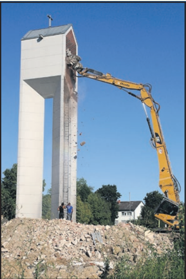
Abriss Kirchturm Kath. Kirche 2013
