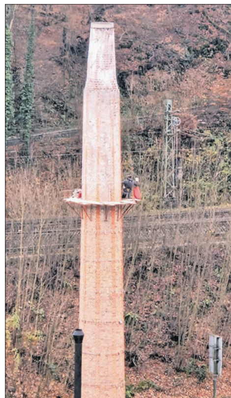
In der vorigen Woche wurde der Schornstein eingerüstet und...
