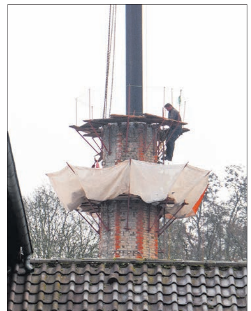
... in den vergangenen Tagen der stark verwitterte obere Abschnitt abgetragen. Foto: bpa
