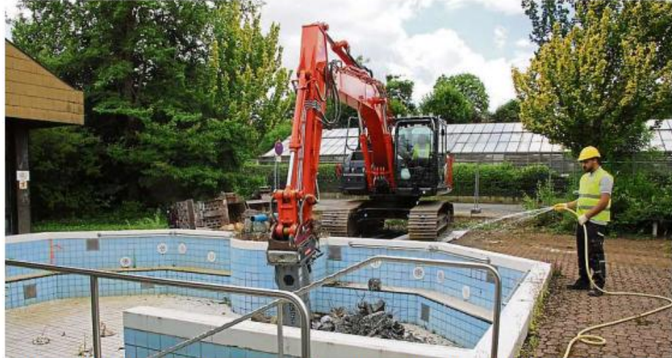
Im Juli wurde mit der Freibad-Sanierung begonnen, das Wärmebecken (hier im Bild) bereits komplett abgerissen. Foto: Petra Hackert
