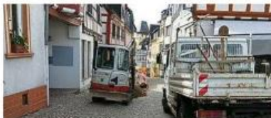
Die Tiefbauarbeiten für die versenkbaren Poller um den Bad Camberger Marktplatz haben begonnen. Foto: Stadtverwaltung
