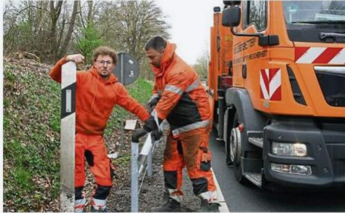
Die Leitplanken an der Beuerbacher Landstraße Richtung vor dem Ortseingang Bad Camberg werden montiert. Foto: Petra Hackert
