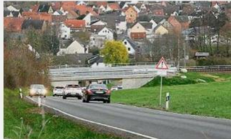
Die Brücke bei Erbach ist das erste Bauwerk, das für Bad Camberger B-8-Umgehung errichtet wurde. 2022 wurde sie fertig.
