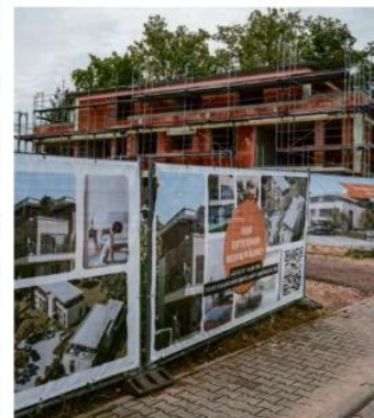
Alles läuft nach Plan. Der Rohbau der ersten 8 Eigentumswohnungen ist fertiggestellt.
