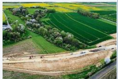
Das Luftbild zeigt den derzeitigen Streckenbau im Bereich der L 3031 in Bad Camberg. Foto: Firma Hegler
