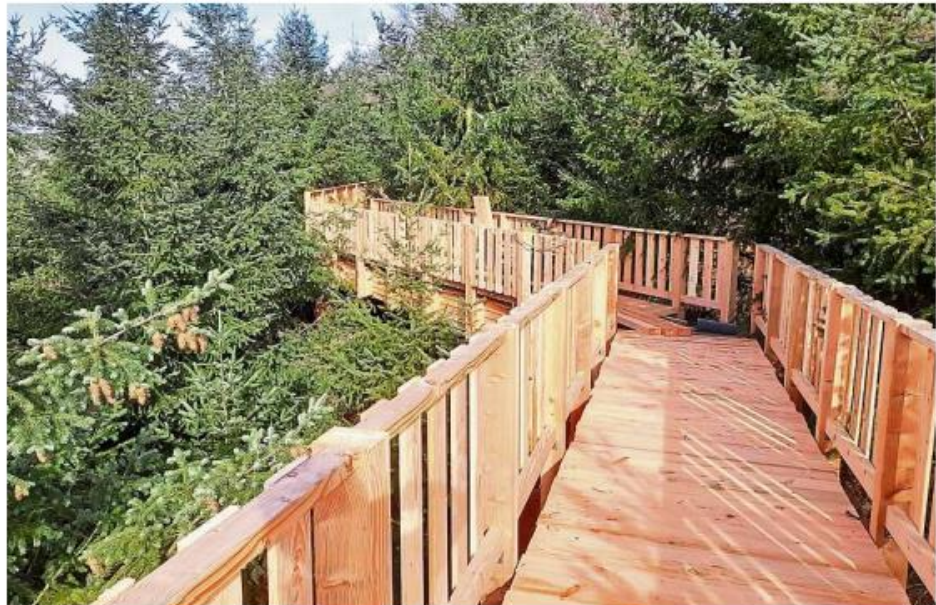
Auf dem Baumwipfelweg können Interessierte die Taunus-Höhenluft schnuppern. Foto: www.baumwipfelweg-bad-camberg.de
