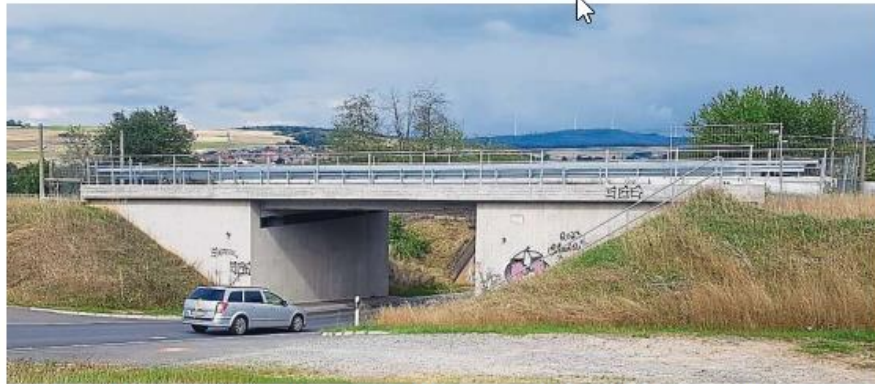
Die Brücke über die Landesstraße 3030 bei Erbach ist bereits fertig. Der Verkehr soll hier 2027 rollen.
