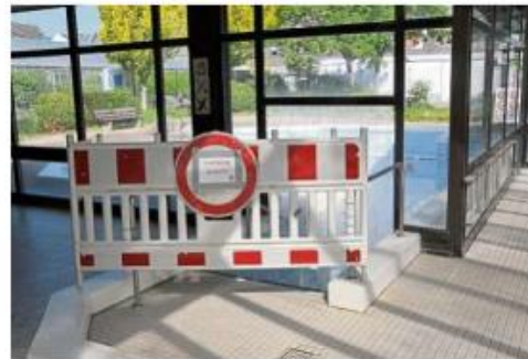
Freunde des Warmwasserbereichs im Bad Camberger Freizeit- und Erholungsbad müssen sich gedulden: Noch ist es gesperrt.
