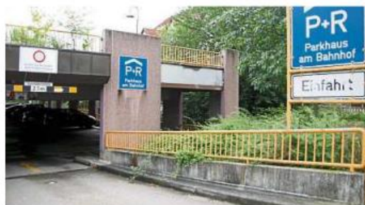
Dicht: Das Parkhaus am Bad Camberger Bahnhof ist ab sofort gesperrt.
