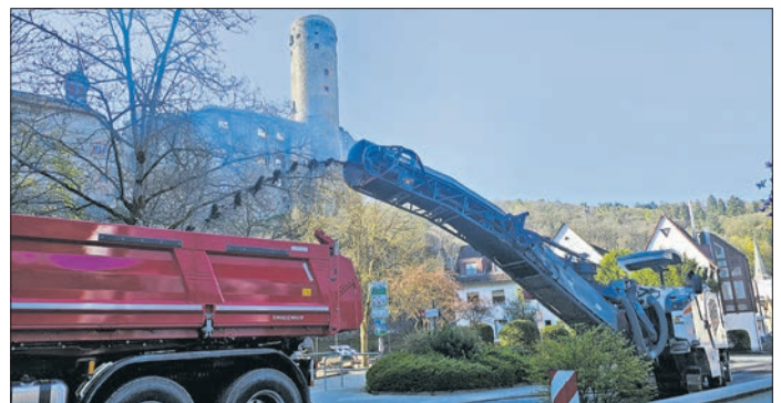
Sanierungsarbeiten in der Rossertstraße mit historischem Hintergrund.
