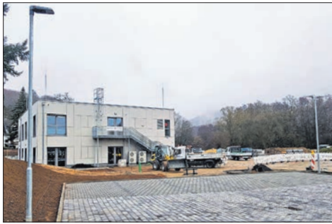
Neue Beleuchtung der Straße Am Hallgarten in Vockenhausen. Im Hintergrund befindet sich der im November eröffnete Kindergarten.
