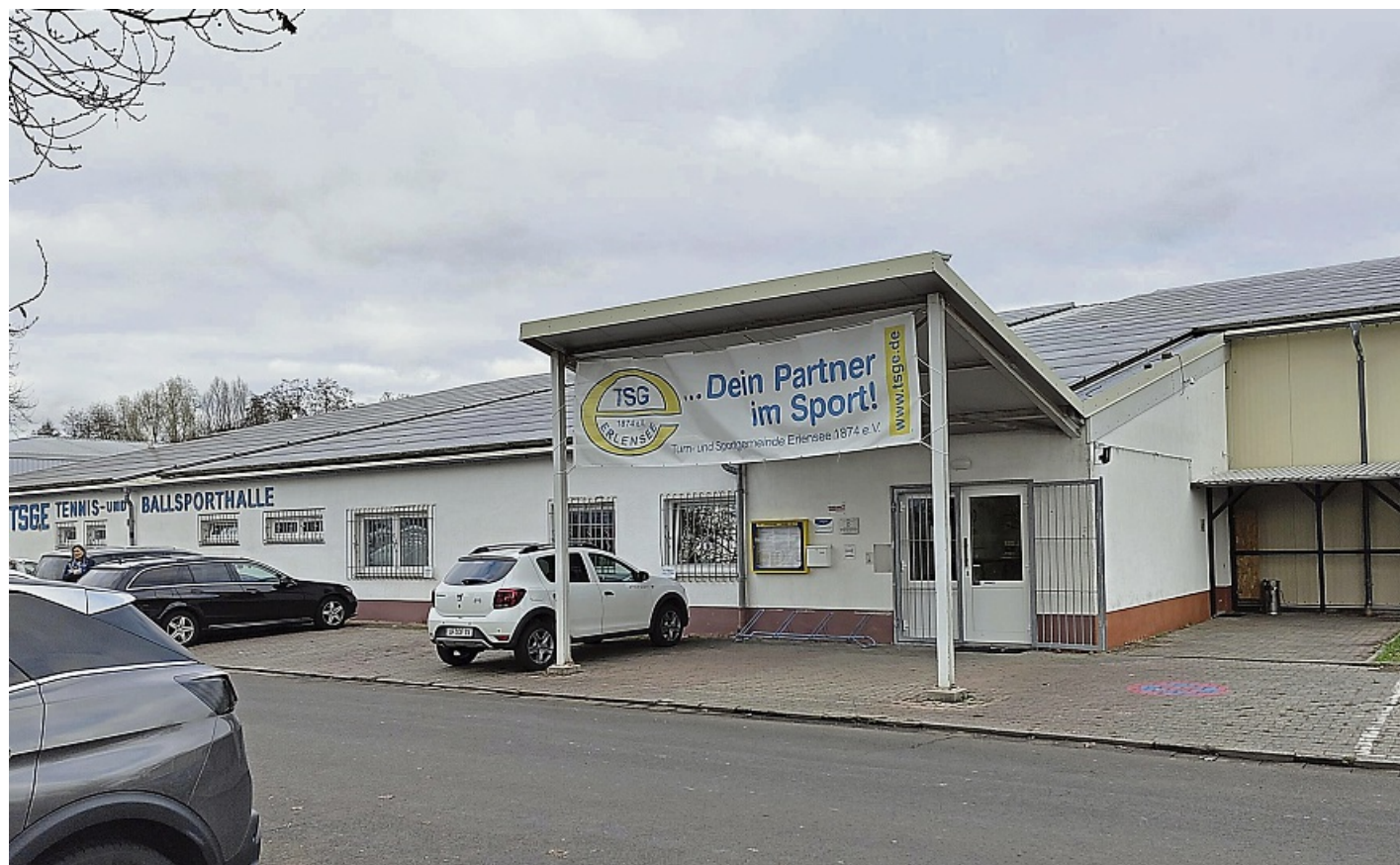
Die Tennis- und Ballsporthalle in Erlensee an der Konrad-Adenauer-Straße ist schon lange zu klein für die mittlerweile 16 Abteilungen des Vereins; sie soll einen Erweiterungsbau bekommen. SABINE MÜLLER
