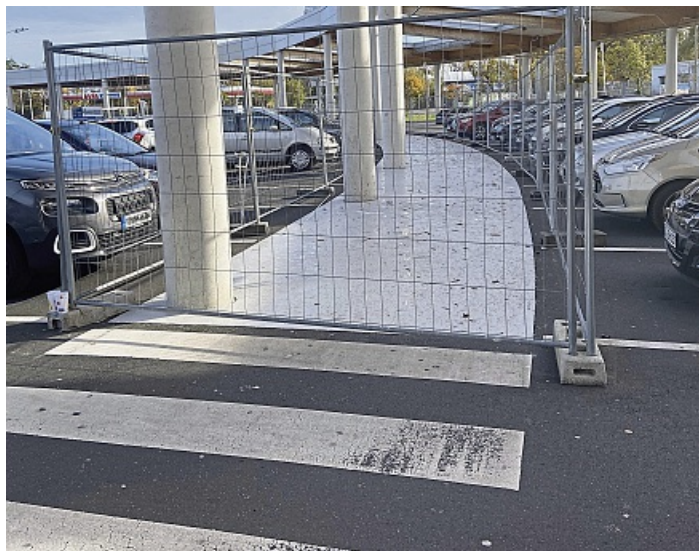
Wegen Arbeiten sind immer wieder Teile des Fußwegs abgesperrt.
