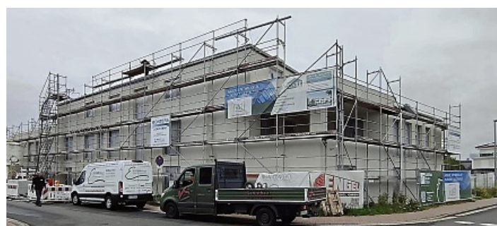
Noch wird fleißig gebaut: Die Einrichtung mit 34 Plätzen entsteht in Langendiebach. Auch Wohnungen für Mitarbeiterinnen und Mitarbeiter gehören dazu. THOMAS SEIFERT
