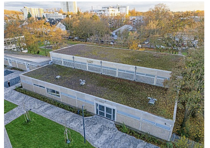
Die Einfeld-Halle soll nun ersetzt werden. Es sollen neun Millionen Euro investiert werden.
