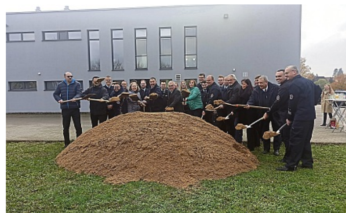
Darauf hat man in Hammersbach lange gewartet: Mit dem Übungsturm wird der Ausbildungsstandort der Feuerwehr gestärkt. PM
