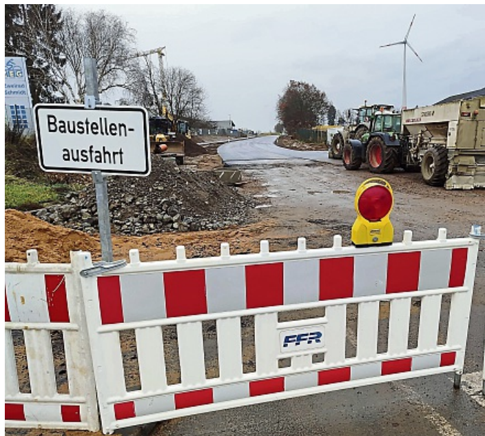
Bis zur Kreuzung mit der Otto-Hahn-Straße in Kilianstädten ist der Neubau der L3009 aus Richtung Windecken fast fertiggestellt. THOMAS SEIFERT
