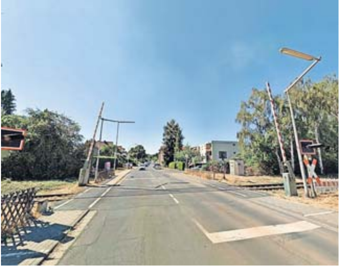
Die Deutsch Bahn baut am Bahnübergang Waldstraße.
