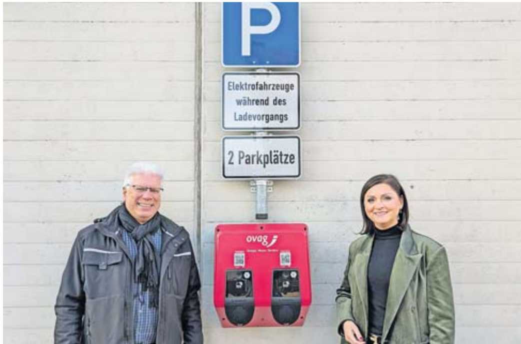
Bauhelfer Wolfgang Triebert und Bürgermeisterin Olga Schneider vor der E-Ladestation.
