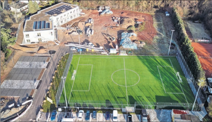
Gesamtansicht: Neuer Fußballplatz mit der öffentlichen Parkplatzanlage (vorne), die Parkplätze des Kindergartens (links) und der Kindergarten selbst.
