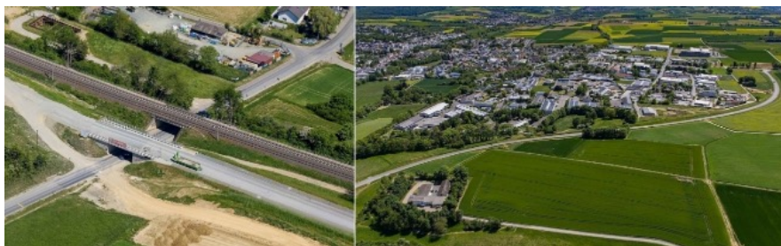
Abb. 16 Brücke über L 3030 (links), Verbindung L 3030 – L3031 (rechts )
