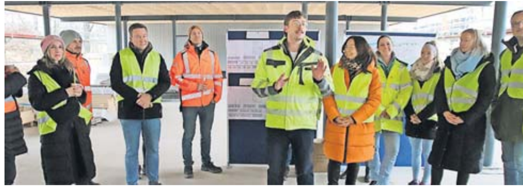
Marc Schmidt, Technischer Leiter Bauwesen (Bildmitte), gab mit seinem Team wichtige Informationen zum aktuellen Stand des Bauprojekts Freibad. Foto: Stadt Schlüchtern
