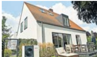
Wärmepumpen mit aktiver Kühlfunktion entziehen dem Haus überschüssige Wärme.
