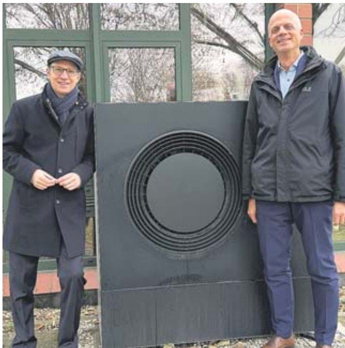
Gemeinsam mit Schulleiter Carsten Treber (rechts) begutachtet Landrat Jan Weckler die modernisierte Heizungsanlage des Bad Vilbeler Georg-Büchner-Gymnasiums, hier die Außeneinheit der neuen Hybrid-Wärmepumpe.
