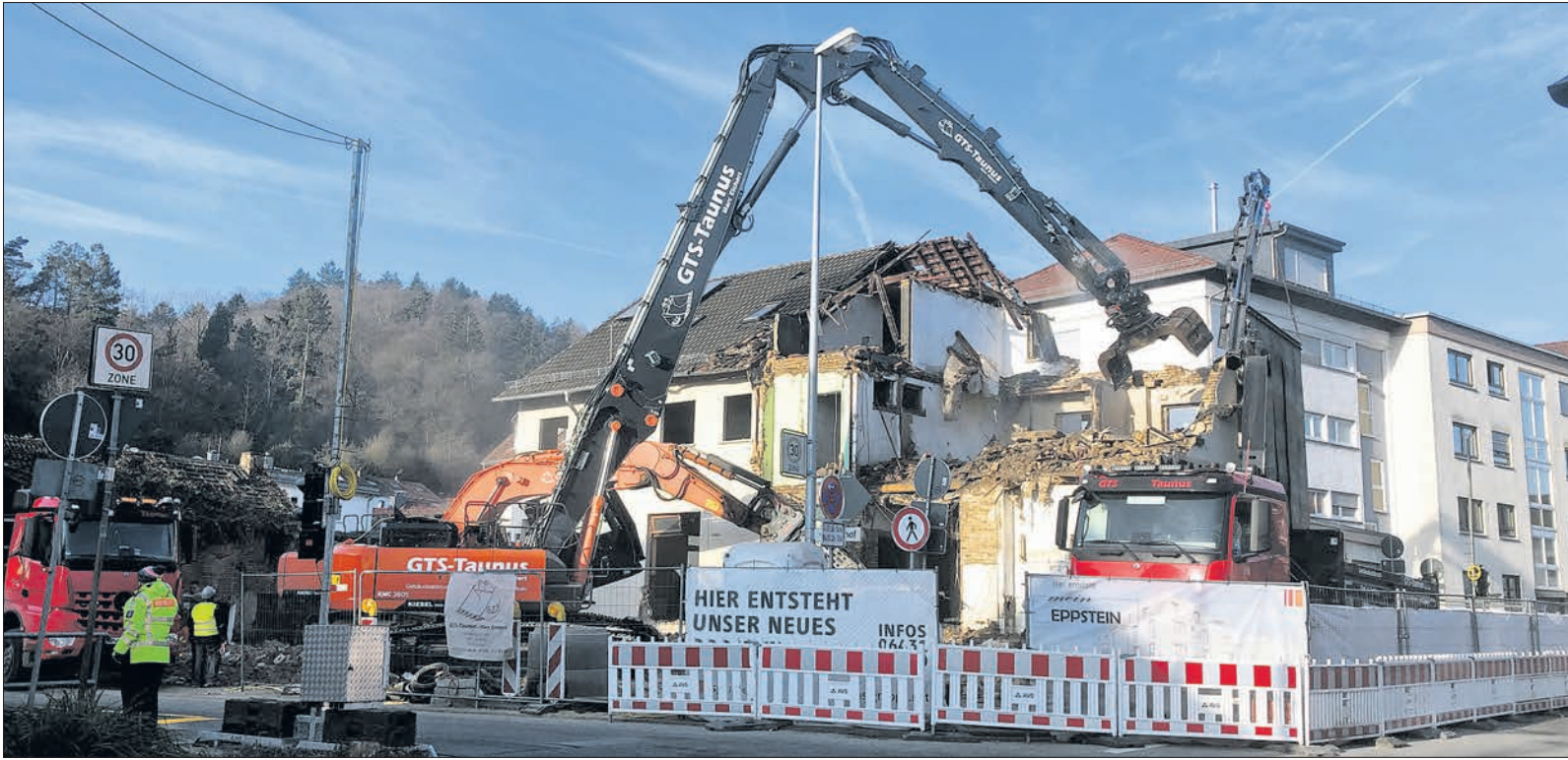
Der Abrissbagger reißt Stück für Stück die Bruchteile aus dem Gemäuer des früheren Gasthofs Zum Taunus.
