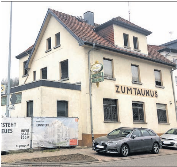
Das Gebäude kurz vor dem Abbruch.
