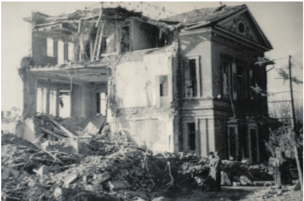
Abb. 3: Die zerstörte Villa Boltendahl
