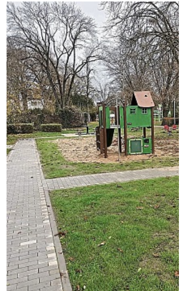
Unter anderem Grünflächen und Wege wurden erneuert.
