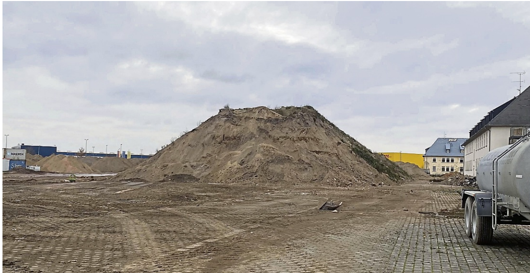
Meterhohe Erdhügel türmen sich auf dem Google-Gelände. Das Unternehmen unternimmt dort umfassende Erdarbeiten. Bis zu fünf Meter tief werden Gruben gegraben. Die Erde wird gesiebt und nachher wieder verfüllt. HOLGER WEBER-STOPPACHER
