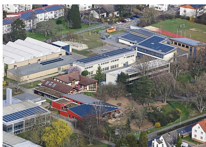
Die Turnhalle der Großkrotzenburger Grundschule ist in einem schlechten Zustand.
