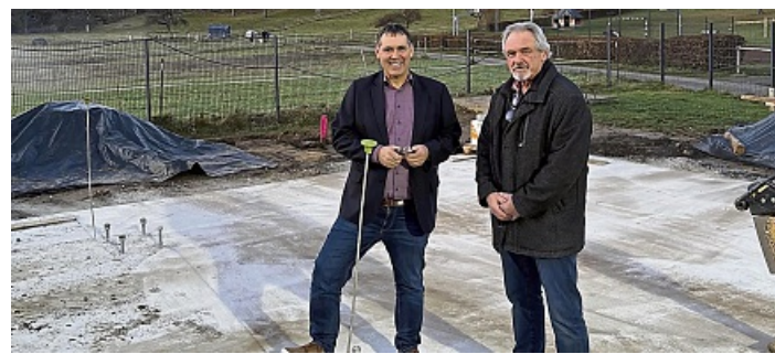
Gemeinsam mit Bauamtsleiter Stefan Brezina (rechts) hat sich Bürgermeister Michael Göllner ein Bild vom aktuellen Stand der Arbeiten am künftigen Übungsturm der Feuerwehr gemacht.
