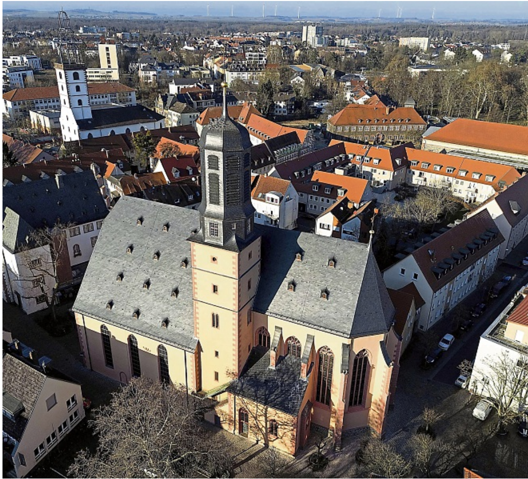
Dach, Fassade, Außenputz und Fenster der Marienkirche in der Hanauer Altstadt sind saniert worden.
