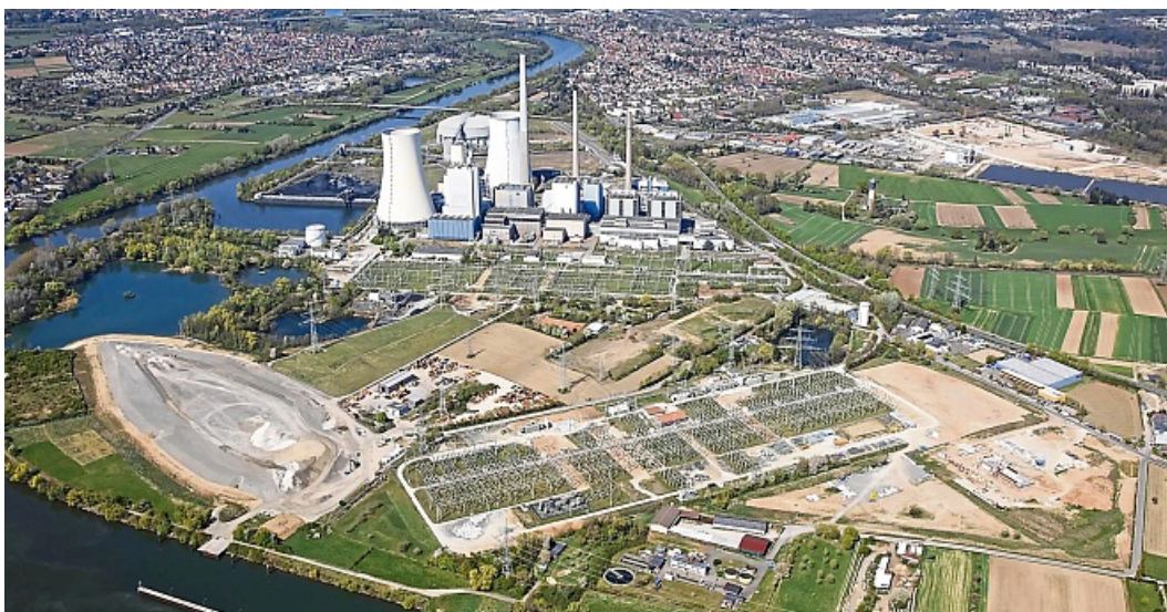
Auf dem Gelände des Kraftwerks Staudinger soll eine Schaltanlage gebaut werden, die als Netzverknüpfungspunkt dienen soll.
