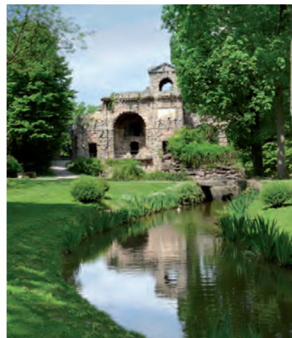
Abbildung 92 — Schwetzingen, Schlossgarten, Aquädukt
