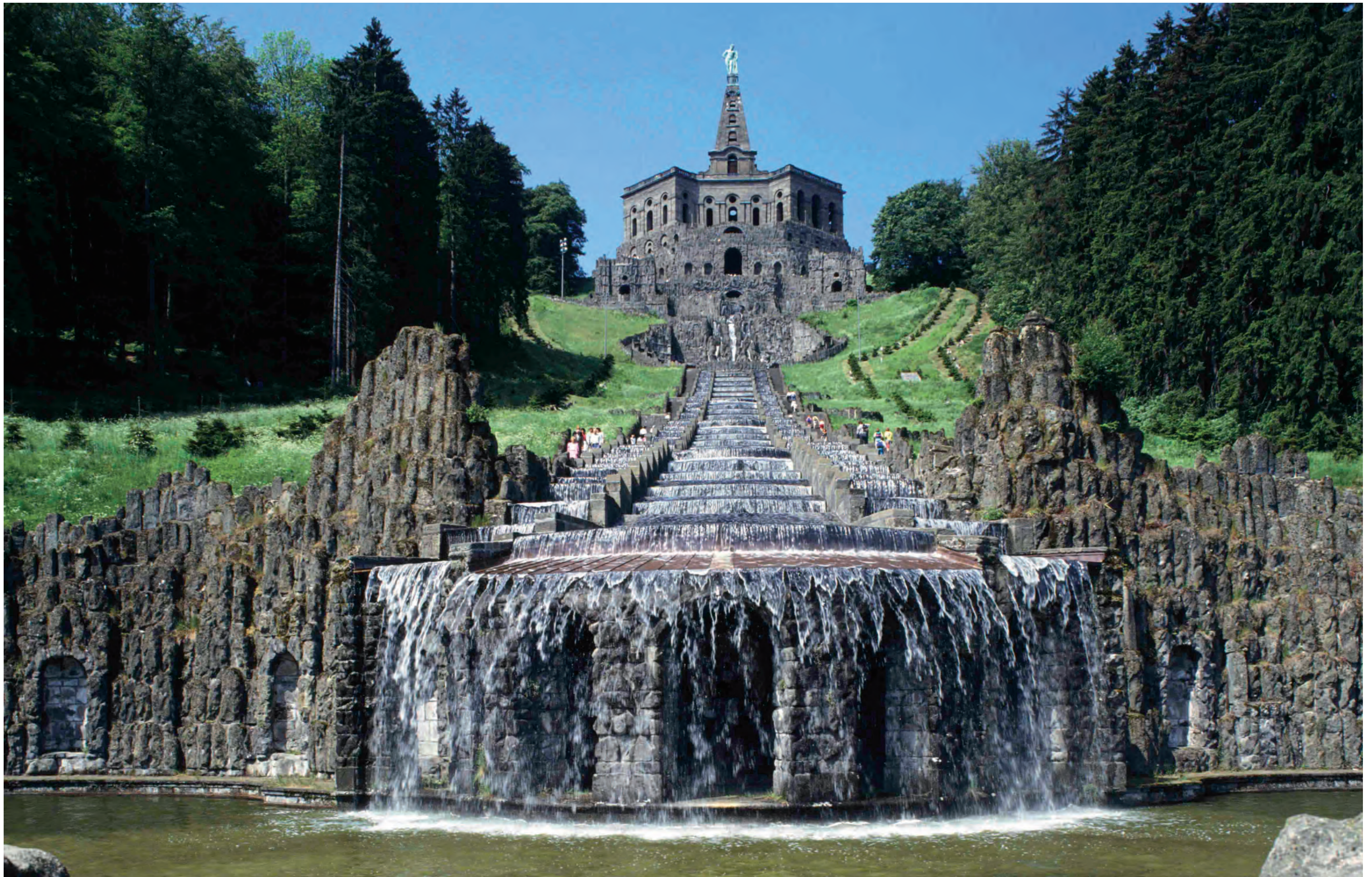
Abbildung 7 — Herkulesbauwerk mit der Großen Kaskade
