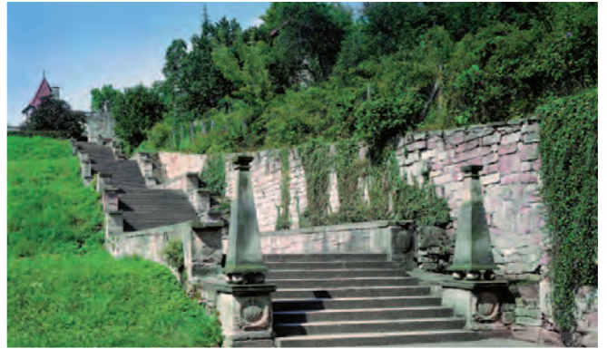
Abbildung 80 — Schmalkalden, Schloss Wilhelmsburg, Treppenwangenkaskade
