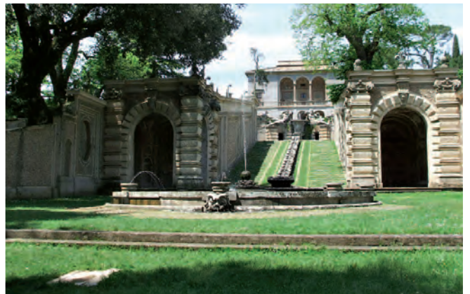
Abbildung 75 — Caprarola, Villa Farnese, Casino mit Wassertreppe
