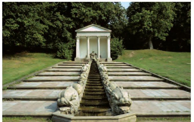
Abbildung 81 — Schleswig, Schloss Gottorf und Neuwerkgarten, Wassertreppe
