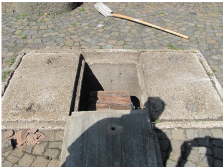
Der verwitterte Gradmessungspfeiler (G) mit Leuchtbolzen im Betonschacht 2018 vor dem Austausch gegen einen Granitpfeiler
