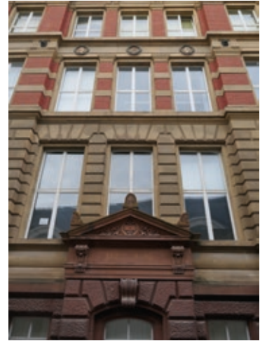
Linker Teil der Nordostfassade
