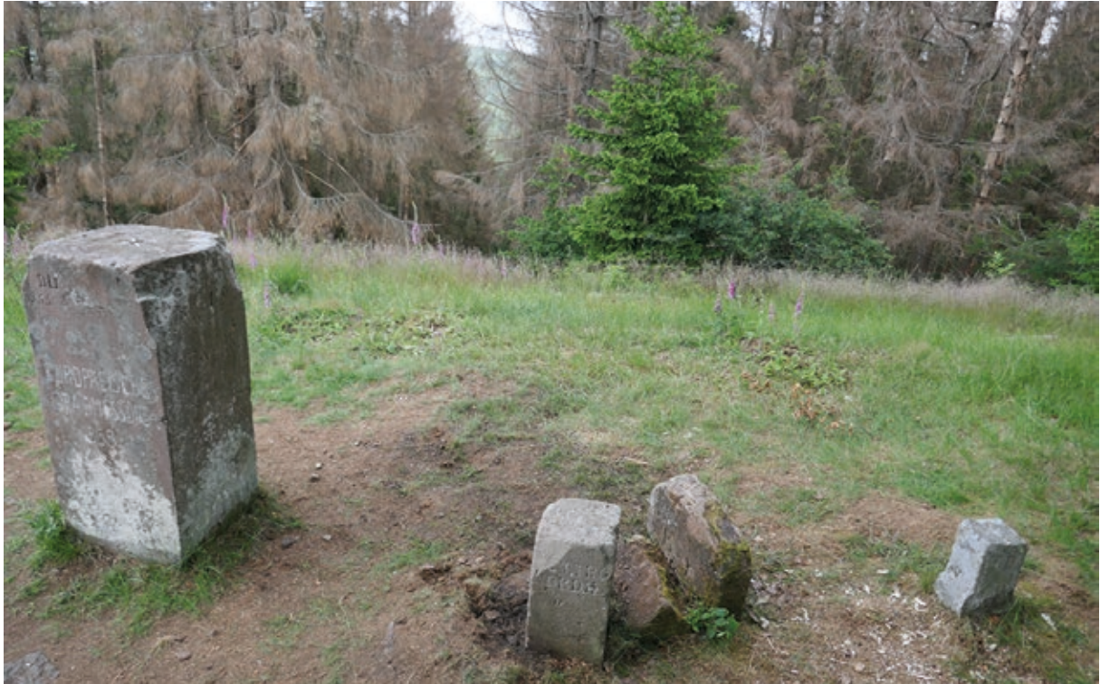
Punktgruppe auf dem Hassenroth aus südlicher Richtung von links nach rechts: Gradmessungspfeiler von 1868, DH-Pfeiler von 1829, abgebrochener historischer Flurgrenzstein von 1829, TP-Granitpfeiler von 1900.
