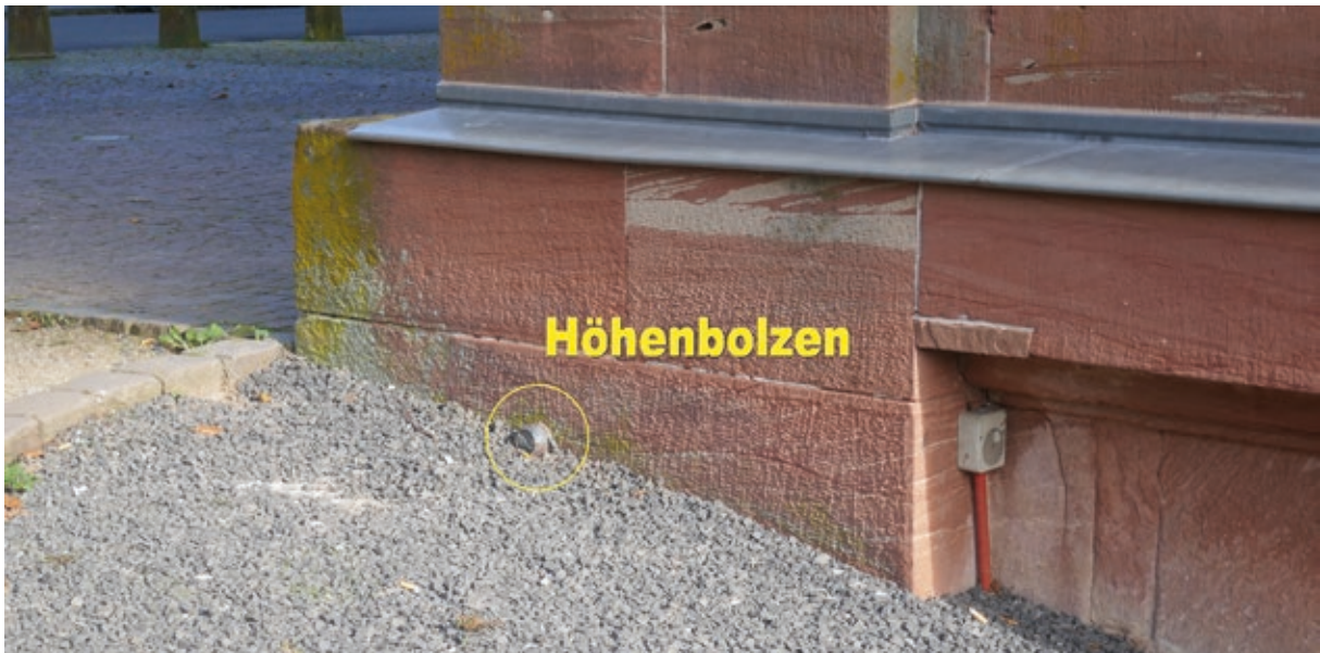
Der Höhenbolzen nahe der nordwestlichen Gebäudeecke
