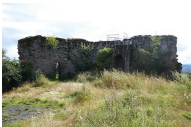
Blick von Gerling's Steinpostament zur Burgruine mit Treppenaufgang zur Aussichtsplattform
