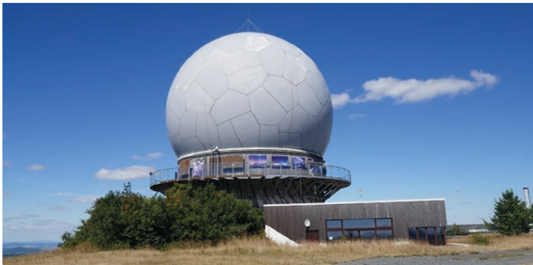
Radom mit Aussichtsgalerie und Blitzableiter am obersten Kuppelpunkt
