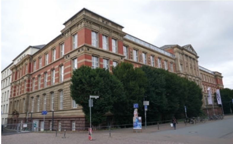
Das Alte Hauptgebäude – Ansicht von Norden
