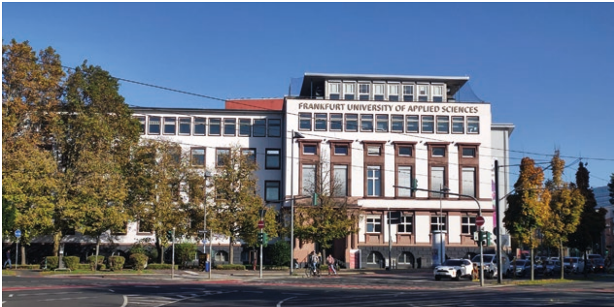
Hauptgebäude der Frankfurt UAS am Nibelungenplatz 1 (Foto: Dr. Katharina Lundenberg, Oberursel)
