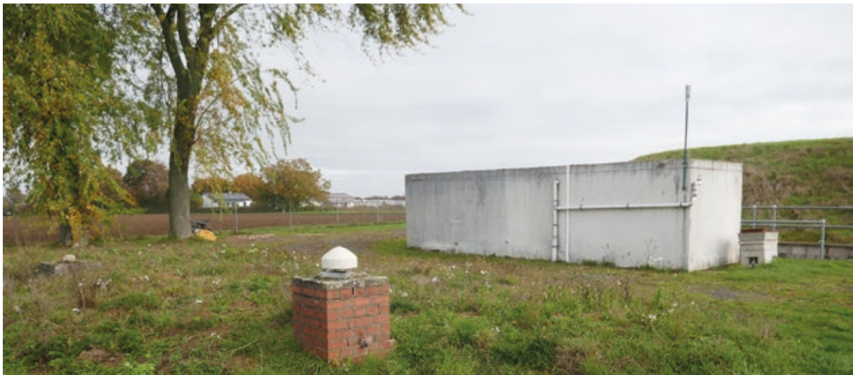
Satellitenbeobachtungsstation Kloppenheim mit GNSS-Antenne
