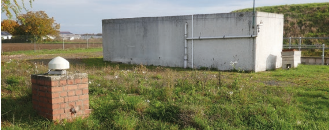
Astropfeiler Kloppeheim mit GNSS-Antenne aus südwestlicher Richtung
