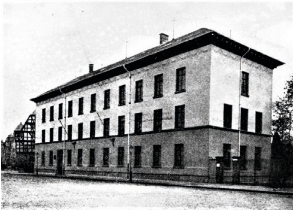
Das 1839/40 errichtete neue Kollegium am Brandplatz (Quelle: JLU Gießen)
