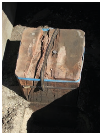
Der verwitterte Gradmessungspfeiler (G) mit Leuchtbolzen im Betonschacht 2018 vor dem Austausch gegen einen Granitpfeiler
