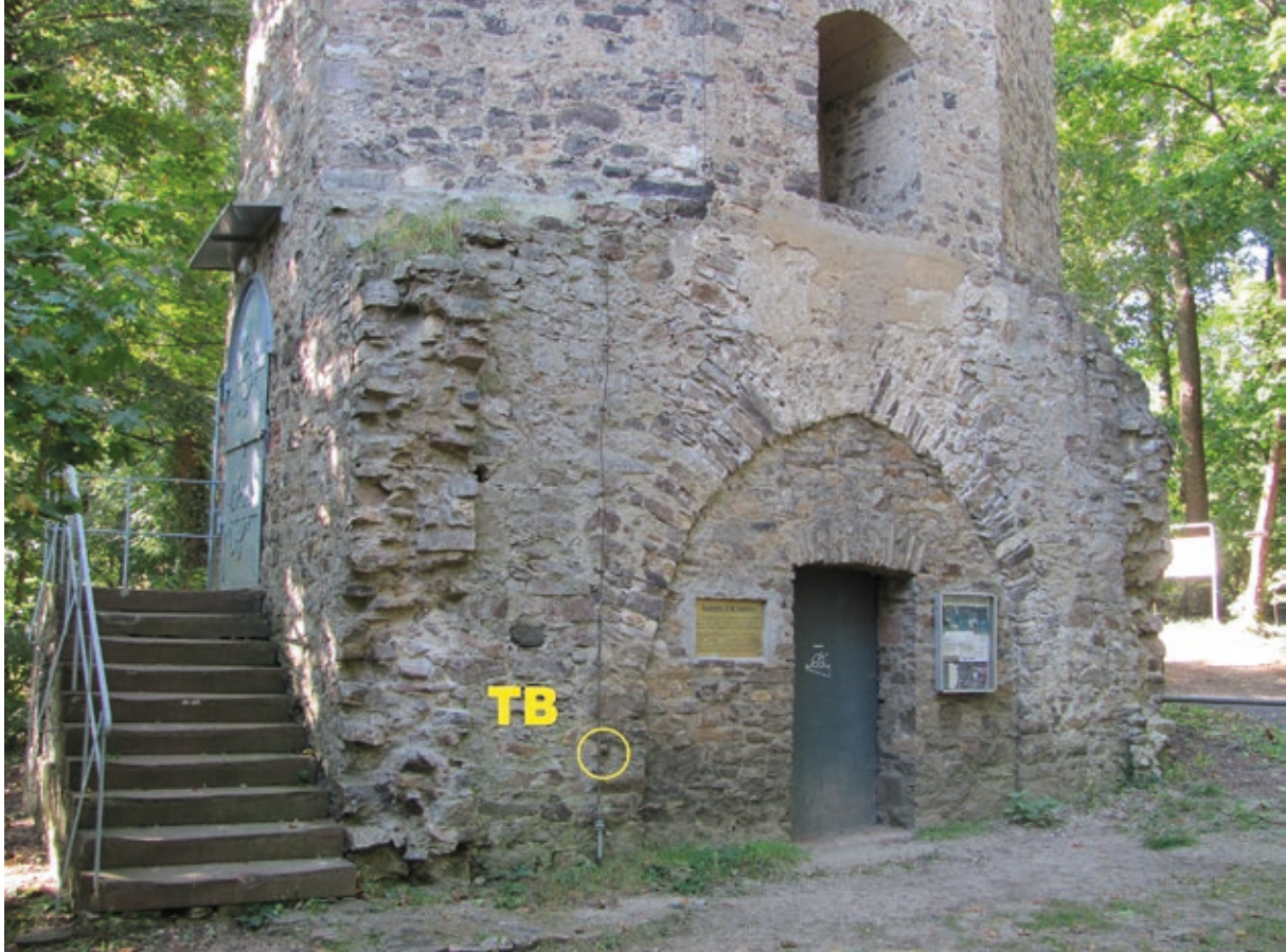
Unterbau des Johannisturmes (Ostseite) mit Turmbolzen (TB, gelber Kreis)
