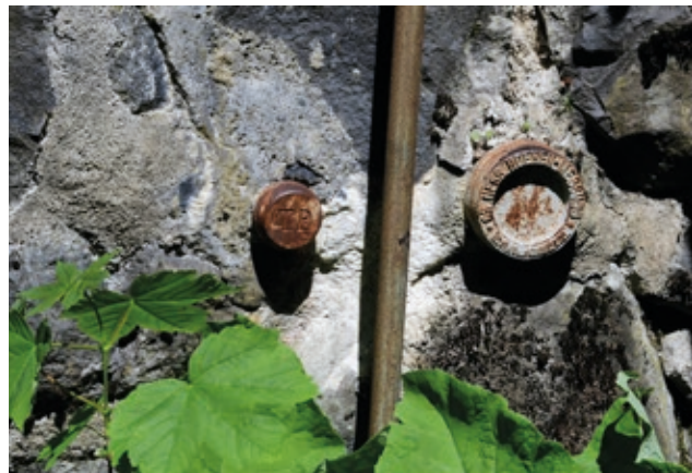
Die Festlegung 1.O. südlich des Bismarckturms Turmbolzen und Höhenmarke östlich des Turmeingangs (Fotos: Bernd Kaiser, Grebenhain)
