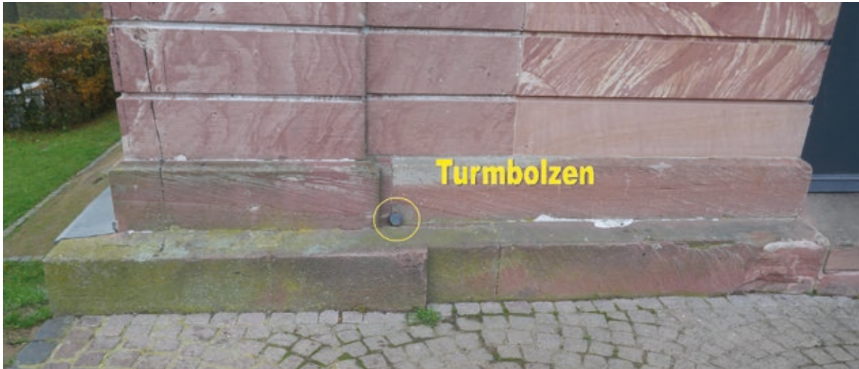
Der Turmbolzen nahe der nordöstlichen Gebäudeecke
