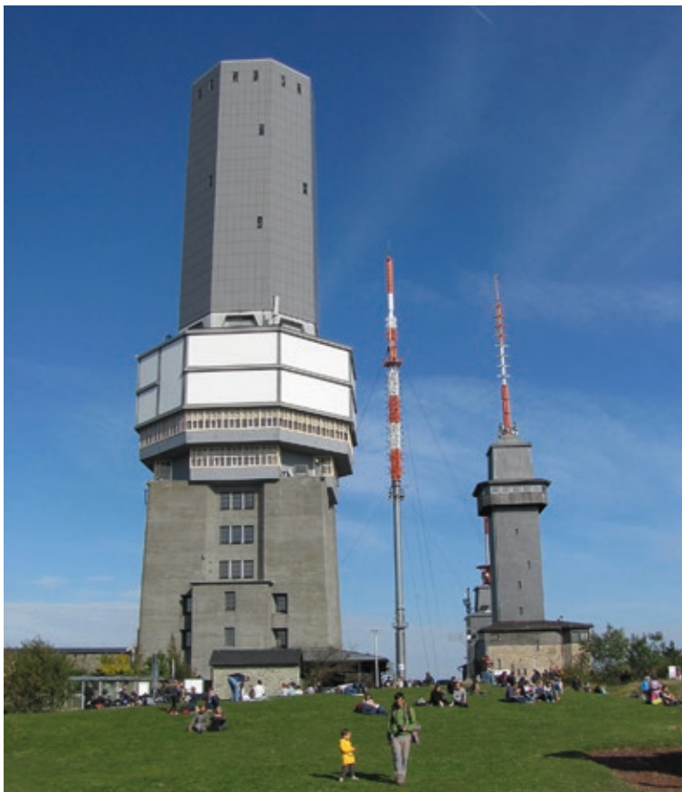
Der hohe Rohrmast zwischen dem alten Fernmeldeturm (links) und dem Aussichtsturm (rechts) aus südwestlicher Richtung
