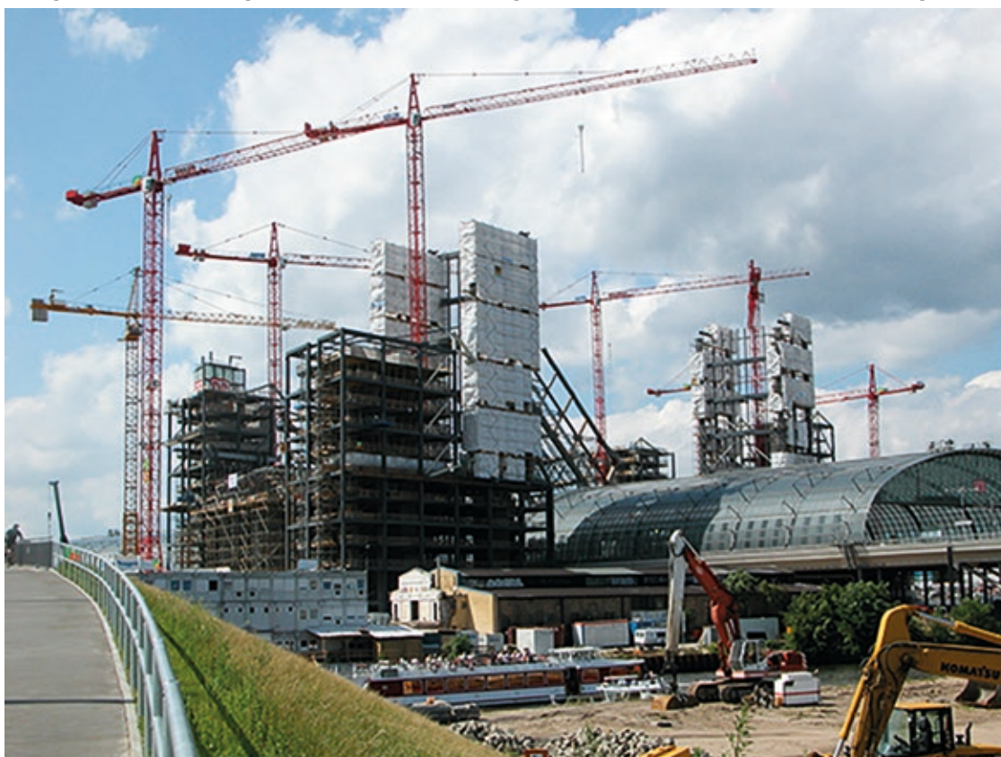
Großbaustelle mit zahlreichen ingenieurgeodätischen Herausforderungen (Quelle: privat)
