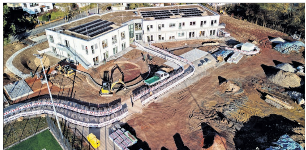
Der Kindergarten in Vockenhausen ist noch über einen provisorischen Zugang erreichbar. In einigen Wochen sollen die Außenanlagen fertig sein. Foto: Jochen Haupt
