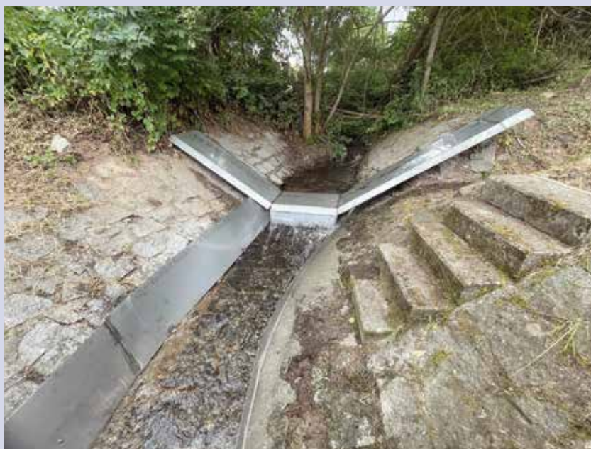
Abbildung 3: Sperre auf Stützschwelle Foto: R. H.
