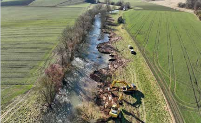
Durch die Abflachung der Uferbereiche wird die Dynamik des Flusses gefördert Foto: AV Hassia Fuldabrück e. V.
