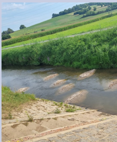
Durch die neuen Kiesflächen entstehen abwechslungsreiche Strukturen wie Flachwasserbereiche, strömungsberuhigte Zonen und tiefere Rinnen.
