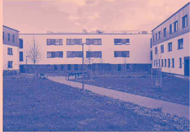
Die neuen Campus-Gebäude
