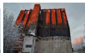
Das Aalto-Silo-Gebäude wird in Oulu zum Kulturzentrum umgebaut.
