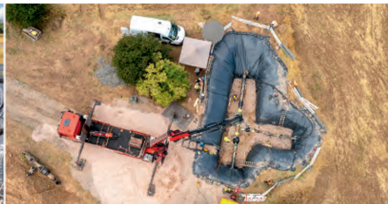
Erneuerung einer Gashochdruck-Armaturengruppe in Wiesbaden-Heßloch.
