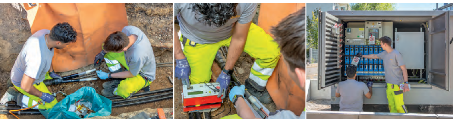
Im Zuge der Arbeiten an der neuen Trafostation in Tst.-Bleidenstadt wurden die 20-kV-Kabelverbindungen montiert, einzelne Phasen identifiziert und beschriftet.
