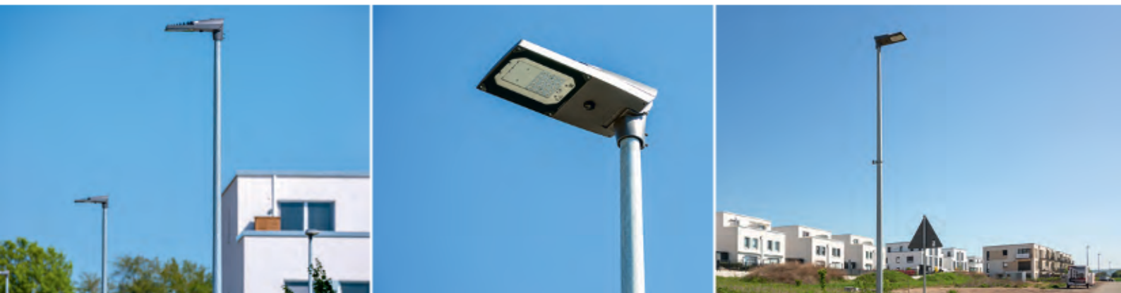
Hocheffiziente LED-Straßenbeleuchtung im Neubaugebiet Wiesbaden-Bierstadt Nord.
