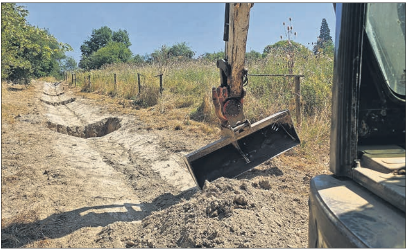
Die Mulden werden mit Steinen gefüllt. Dort versickert das Regenwasser. Die neu angelegte Rinne wird nach und nach überwachsen und trotzdem als Abfluss fürs Regenwasser dienen.
