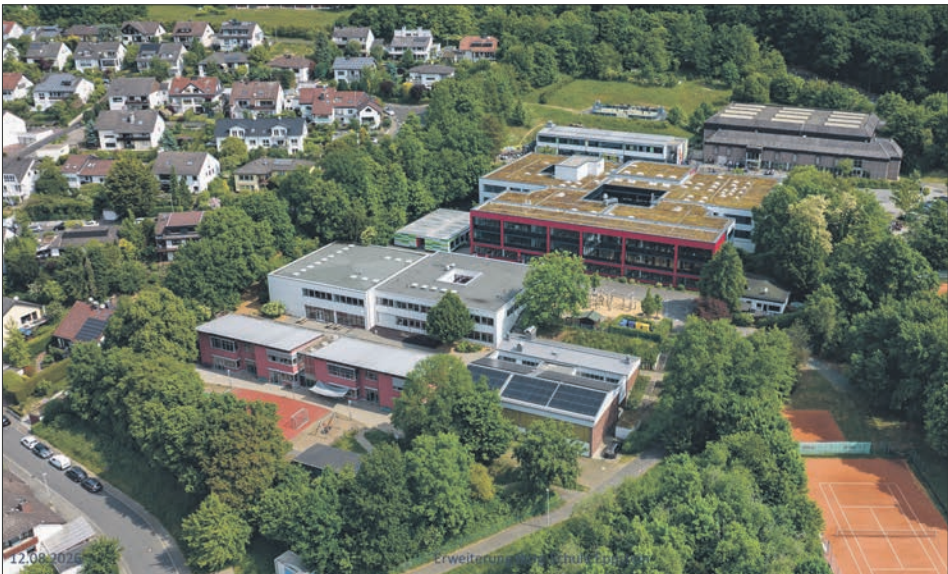
Die Burg-Schule am Schulstandort Eppstein soll erweitert werden. Anstelle des alten Holzpavillons am unteren Grundstücksrand oberhalb des Eppenhainer Wegs will der Kreis ein zweigeschossiges Betreuungsangebot bauen und im Untergeschoss Richtung Eppenhainer Weg eine Mensa. Foto: MTK-Pressestelle/CopterCam AG
