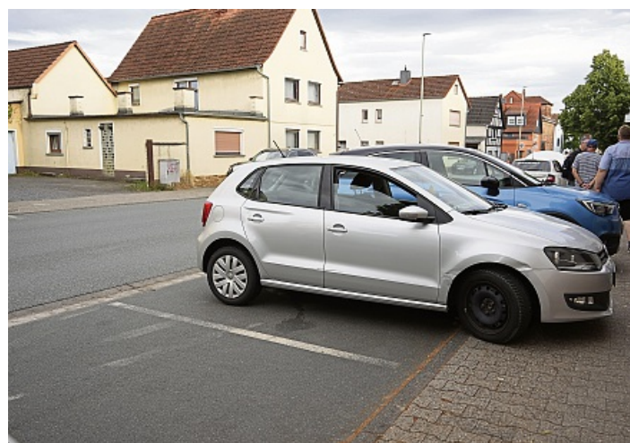
Die Parkplätze in der Südlichen Hauptstraße in Höhe der Häuser Nr. 23 und Nr. 25 sind zu kurz. Dadurch ragen parkende Autos in den Gehweg hinein. Der Ortsbeirat wünscht sich eine neue Anordnung, parallel zur Straße.
