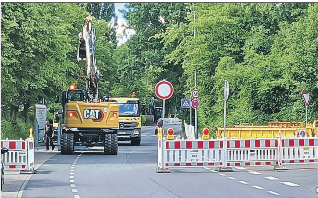
Spätestens am Samstagabend sollen die Baustellen-Baken auf dem Westring verschwunden sein. Nach zehn Monaten sind die Bauarbeiten abgeschlossen. Archivfoto: Schlosser
