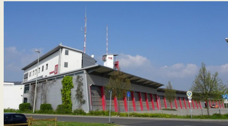
Neue Feuerwehr, in Betrieb seit 2003
