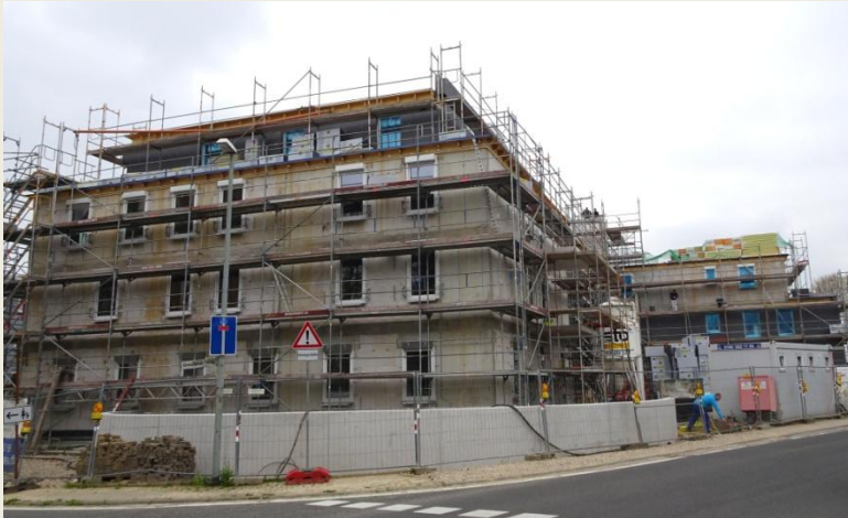
Neubau der HWB an der Frankfurter Straße
