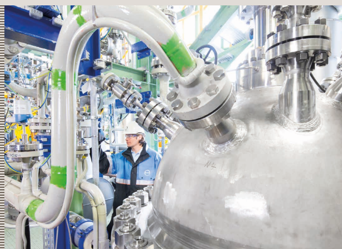
CO 2 statt Erdöl nutzen – Blick in eine deutsche Chemieanlage, die Kohlenstoffdioxid als Rohstoff für die Herstellung von Kunststoffen verwendet.
