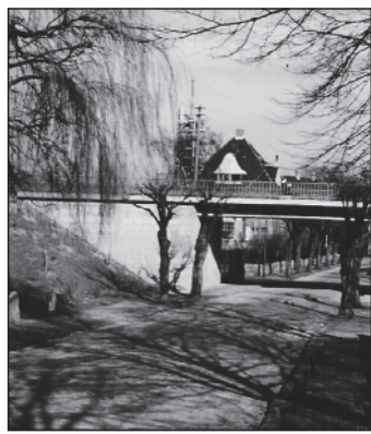
Jenseits des Pfingstborngrabens lag die Villenkolonie.
