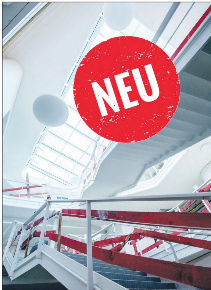
Die letzten Gerüste sind weg: Der Neubau der Ludwig-Weber-Schule ist fertig und wird nun bezogen.
