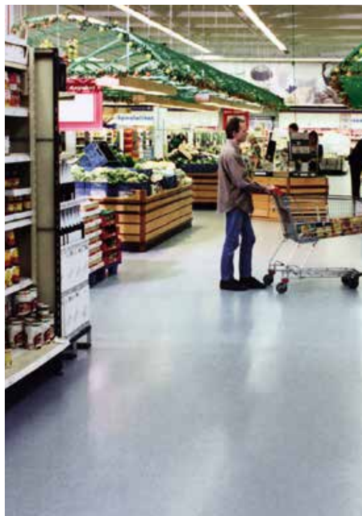
MMA-Bodenbeschichtung in einem Supermarkt
