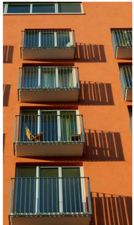
Verputzte Hausfassade mit Wärmedämmung
