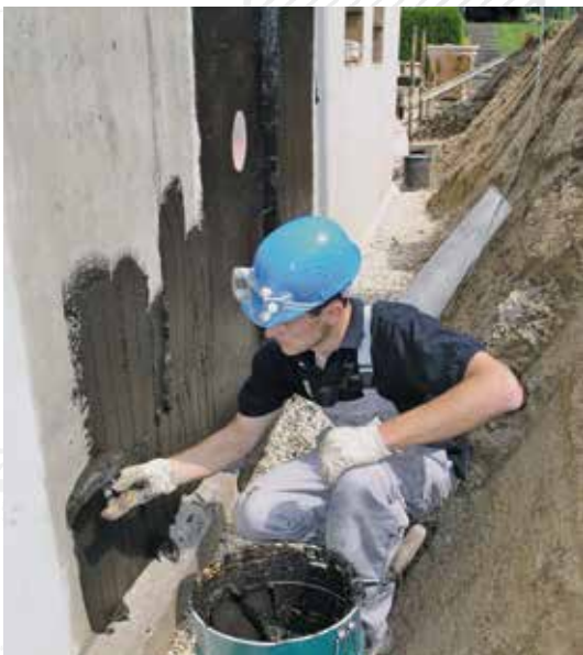
Auftrag einer Bitumendickbeschichtung
