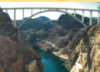
Hoover Damm, USA
