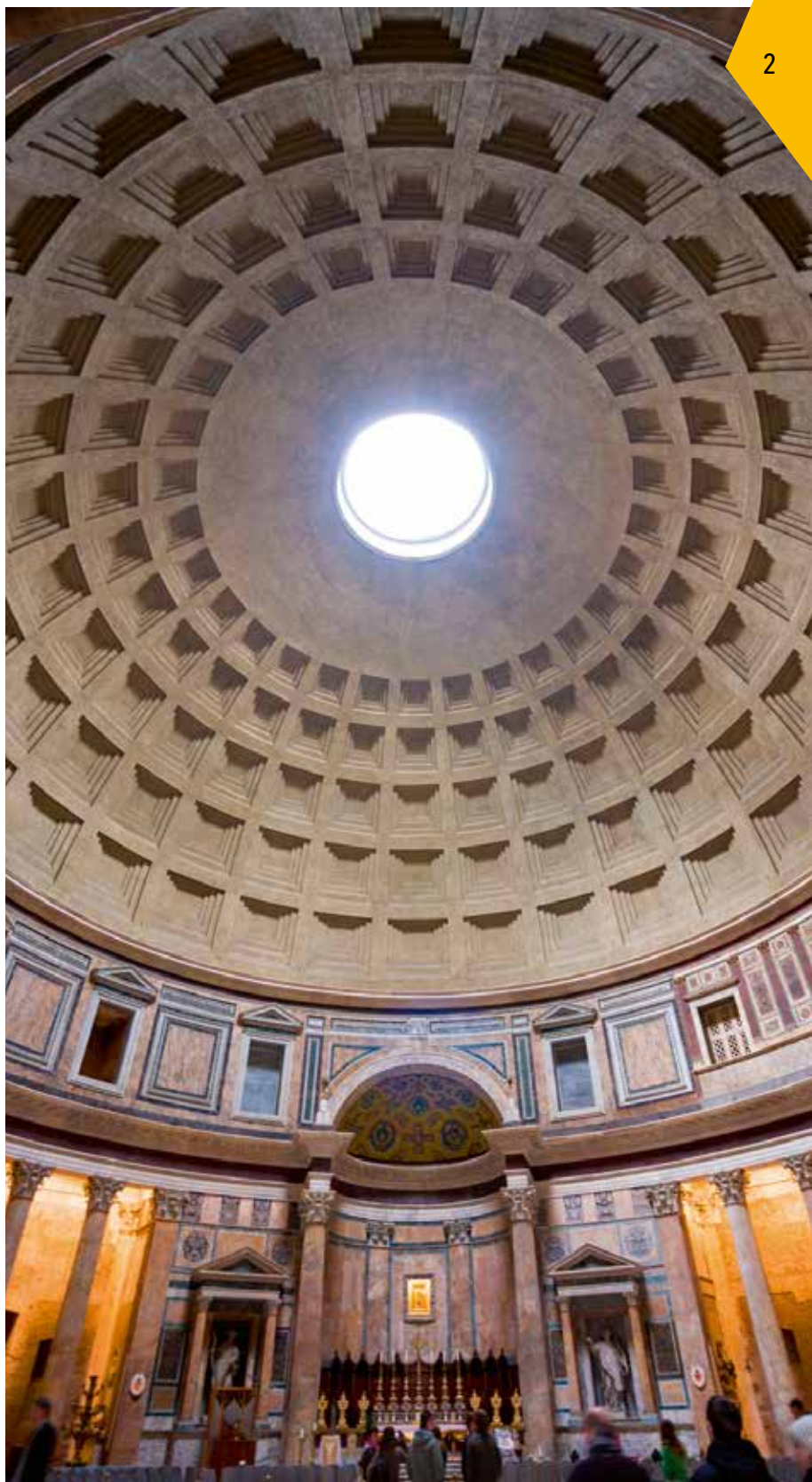
Römischer Beton in Vollendung: das Pantheon in Rom
