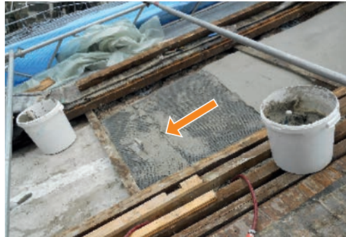
Carbonbewehrung im Detail
