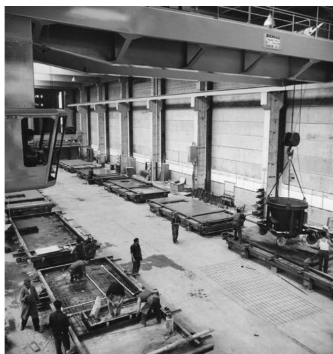
Fertigteilwerk Hinteregger in Neufahrn: Formtische der Werkhalle, Einlegen der Armierung, Einbringen des Betons (Foto: Otto Wasow, Hinteregger, Neufahrn)
